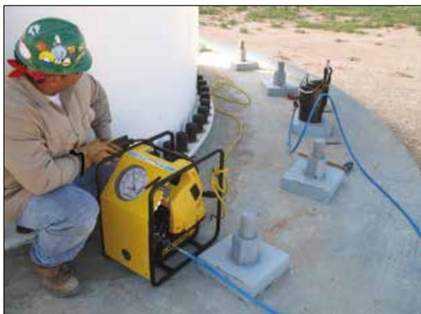
◀ Насос ZUTP-1500 отличается высокой прочностью, малой массой и компактностью, позволяющей выполнять работы в условиях недостатка места. При использовании для работ по затяжке болтов в удаленных местах он может обеспечивать ускорение выполнения работ вдвое по сравнению с конкурирующими моделями.
